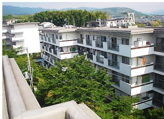
<緑濃い環境にある円明寺ヶ丘第1住宅>
