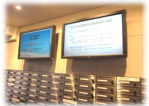
住民への広報は玄関ホールに設置された 2台のモニターを活用
