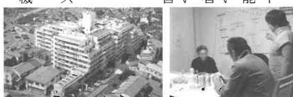
築30年を期して委託管理から自主管理に切り換えたルミエール西京極。ここでは全住民の共通目的である「未来構想」を掲げて住んでよかったと思えるマンションづくりを進めている。右の写真は店舗だった所を管理組合法人が買い取って管理組合事務所として使用しており、ここで管理組合事務局も活動している。
