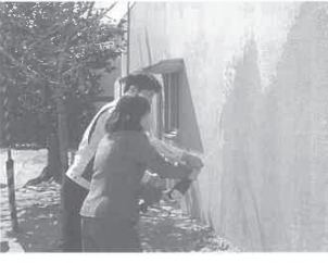
住まわりのハイソの3回目大規模修繕の着工式。安全祈願のシャボンパンをかける岡田佐江子理事長と建築工業㈱の佐井清人現場代理人。コンサルを入れずとも工事現場には必ず管理組合の代表者が同行し、大規模修繕工事の進捗や安全確認など、共同定期点検を行なってきた経験が生きている。
